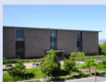
船井交流センター アスレチックルーム トレーニングルーム
